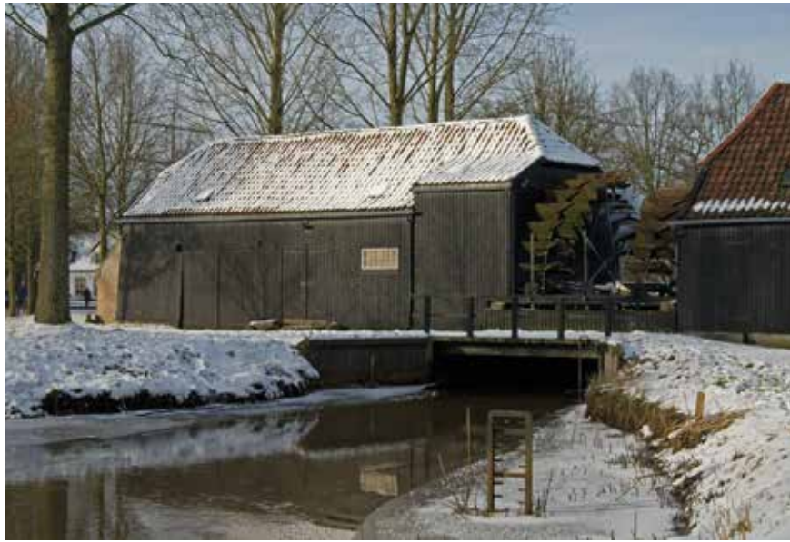
◀ De molenpegel van de Collse molen. Op veel molens geldt het van oorsprong Middeleeuwse stuwrecht nog steeds. Het is daarmee betekenisvol immaterieel erfgoed. Bezit van het stuwrecht betekent dat de watermolenaar nog steeds het recht heeft om het water op te stuwen tot de hoogte die de pegel aangeeft, Saxifraga-Marijke Verhagen, 2010.
