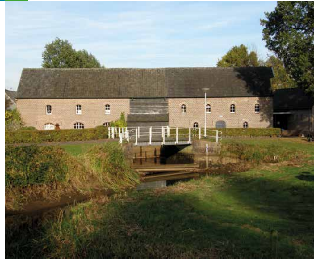
▲◀ Voorbeeld uit het veld van het effect van de stuwschaduw bij de Spoordonkse molen, Hans de Mars, 2008. Een tijdelijke peilverlaging op de molen met 1,40 m (foto links) liet ruim 1 kilometer stroomopwaarts van de molen (foto rechts) nog een meter verlaging van het beekpeil zien. Het effect bleek zelfs door te werken tot aan Landgoed Baest. Zonder de opstuwingspeil zou het beekdal hier verdrogen, zoals op veel plaatsen sinds het begin van de twintigste eeuw in het stroomgebied is gebeurd na het verdwijnen van de molens.
